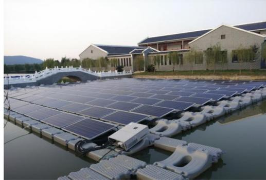
水面光伏电站用浮体及应用实景
